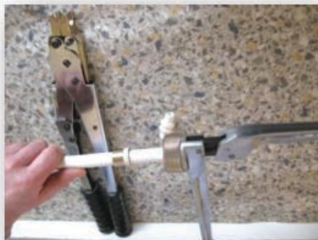
4. Navlačenje čaure na spojnicu završavanje spoja
