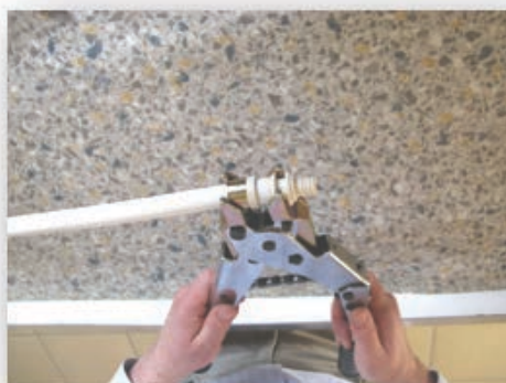
4. Navlačenje čaure na spojnicu završavanje spoja
